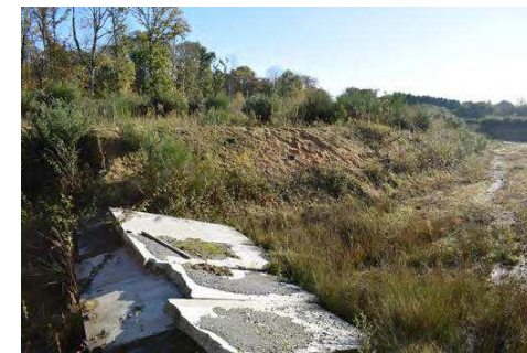
Figure 26 : Présence de dépôts de d'éléments de démolition
